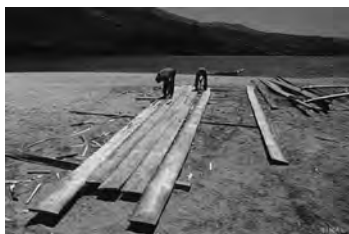
Tábuas do fundo cortadas e assentes no chão plano
