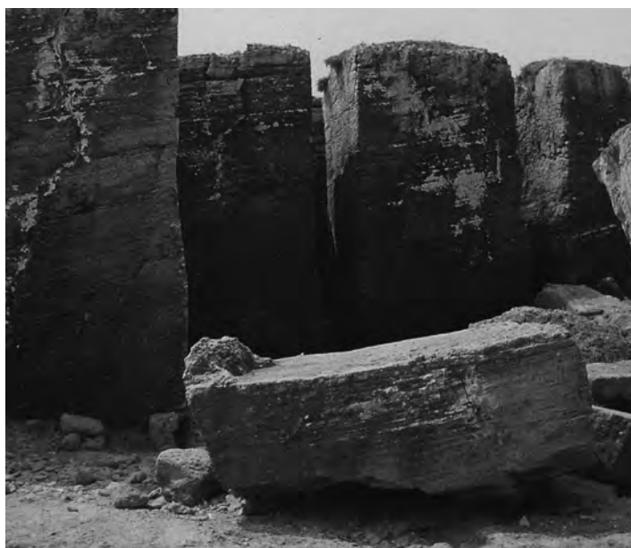
19 - Blocos de pedra cortados para a construção do dique do porto da Ilha do Pessegueiro
