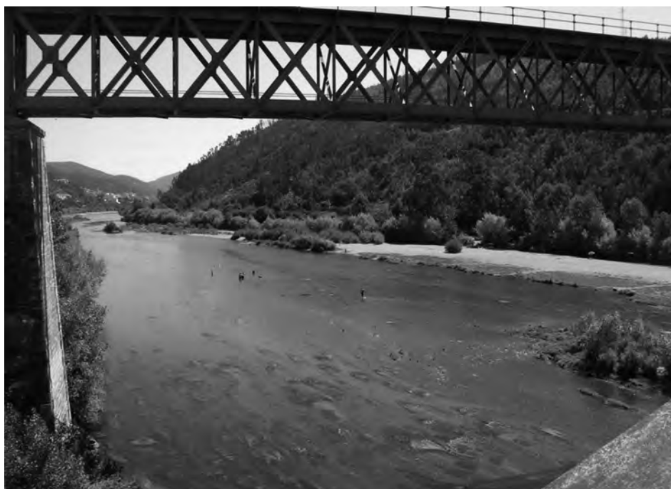
Rio Mondego – ponte da Portela
