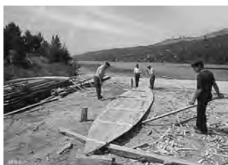
O Tabuado do fundo cortado e fixo por travessas provisórias
