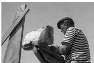
Fixação da chumaceira à roda de popa e à última tábua do costado
